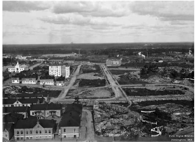
9. Kadunrakentamista Helsingissä Signe Branderin vuonna 1913 ottamassa valokuvassa. Kuvan perusteella kalliota on louhittu, työstetty ja siirretty pitkälti käsityömenetelmillä ja puisilla nosturiviritelmillä.
