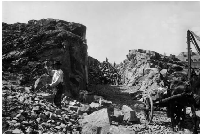
10. Kadunrakentamista Helsingissä Signe Branderin vuonna 1913 ottamassa valokuvassa. Kuvan perusteella kalliota on louhittu, työstetty ja siirretty pitkälti käsityömenetelmillä ja puisilla nosturiviritelmillä.
