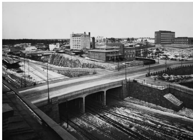
8. Teollisuuskadun ylittävä Sturenkadun silta 1930-luvulla otetussa valokuvassa. Sillan yhteyteen on rakennettu korkeita kivipenmuureja, joilla rautateiden vaatima maasto on pengerretty. Taustalla näkyy vielä suhteellisen rakentamaton Vallilan teollisuusalue, jonka katuja pengerrettiin niin ikään korkeilla kivimuureilla (ks. luku 3.8).
